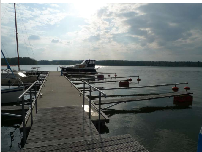
Steganlage in der Nähe
